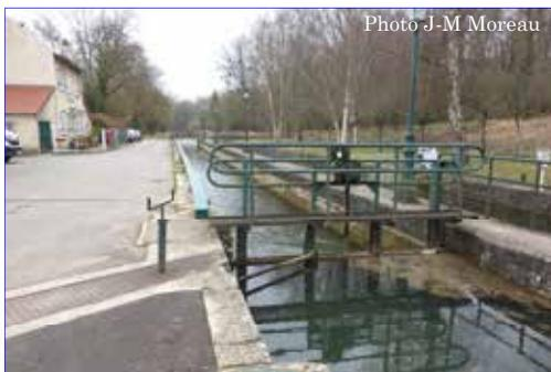
La porte amont à un seul vantail en position de fermeture. Le dispositif actionnant les vantelles est au centre de la porte et accessible depuis la passerelle. On ouvre la porte avec la manivelle à gauche sur le chemin de halage.
