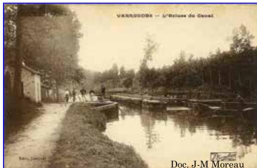
Une autre vue de l'écluse, prise en amont vers 1950. On voit les deux sas et l'îlot central. Sur le chemin de halage, l'éclusier et sa famille prennent la pose.
