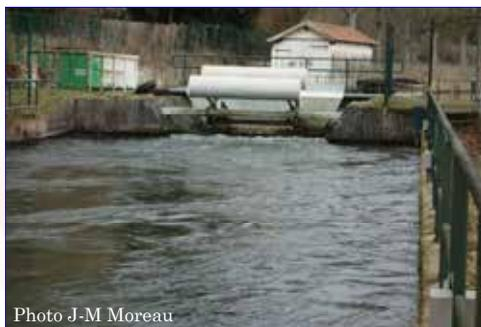
Le système à contrepoids sur le canal de dérivation. En amont de l'écluse, un barrage flottant stoppe les herbes, branchages, feuilles et autres objets flottants avant qu'ils ne s'engagent dans l'écluse ou dans le canal de dérivation. Le garage en arrière-plan abrite une grue utilisée périodiquement pour retirer les embâcles accumulées.
