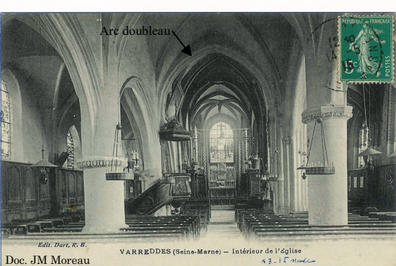
Sur cette carte postale, on voit bien l'arc doubleau n°5 et la pile n°1, au niveau de la chaire.
