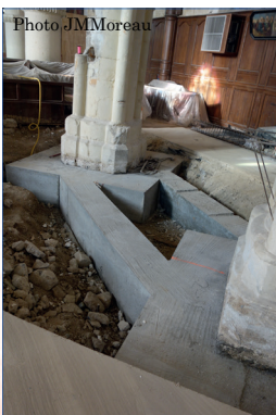
Une vue des travaux.
