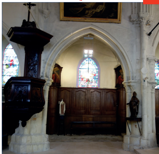
Les 2 piles et l'arc formeret, vestiges restant de l'église du 12 ème siècle.
