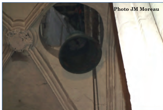
Passage de la cloche par la trappe, début de la descente.
